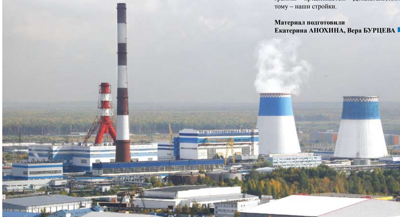
ПГУ-450 Правобережная ТЭЦ
