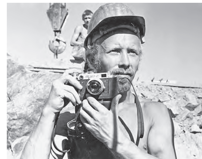
► Стройотрядовец П. М. Маркин на Подужемской ГЭС Student construction brigade Pavel Markin at Poduzhetskaya HPP
