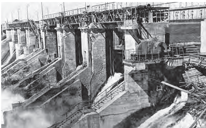
▶ Восстановительные работы на плотине Нижне-Свирской ГЭС Dam reconstruction at Nizhne-Svirskaya HPP
