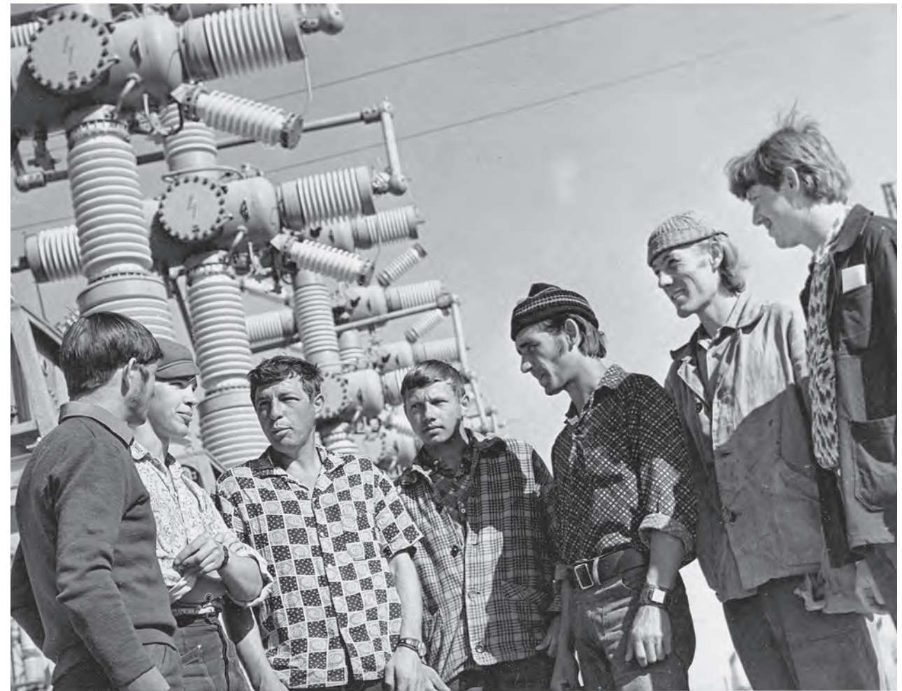
Серебрянская ГЭС-1. Молодежная бригада монтажников Serebryanskaya HPP-1. Young moulder team
