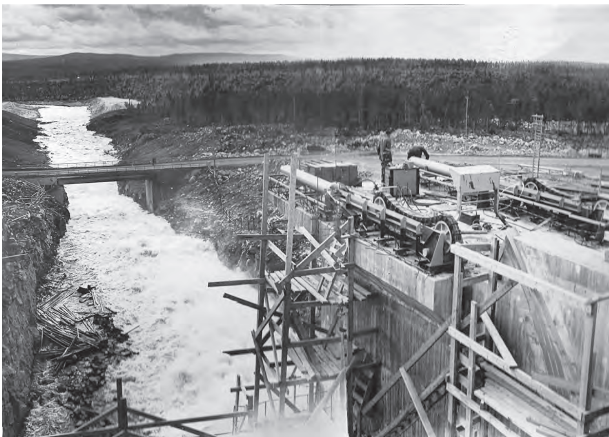
▲ Верхне-Тулумская ГЭС. Строительство водосброса Verkhne-Tulomskaya HPP. Spillway construction
