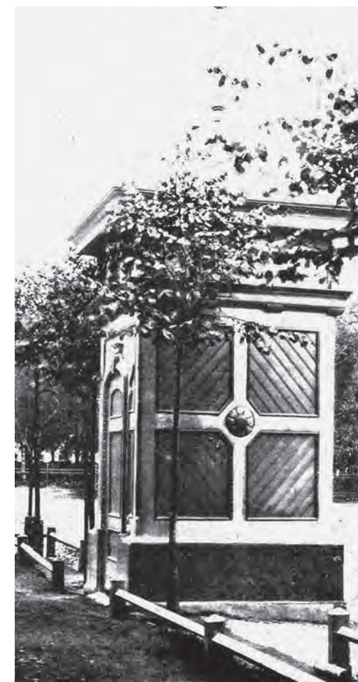
Распределительный пункт (однофазный деревянный)
