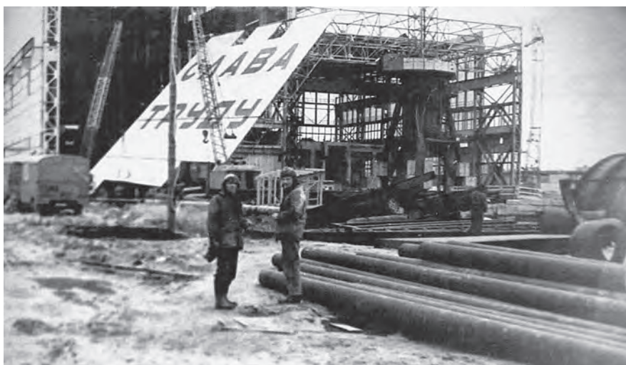
◀ Петрозаводская ТЭЦ. Строительство главного корпуса Petrozavodskaya CHPP. Main unit construction
