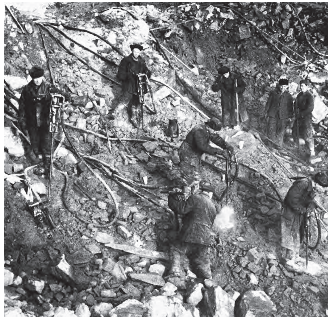
Княжегубская ГЭС. ▶ Строительные работы Knyazhegubskaya HPP. Construction work
