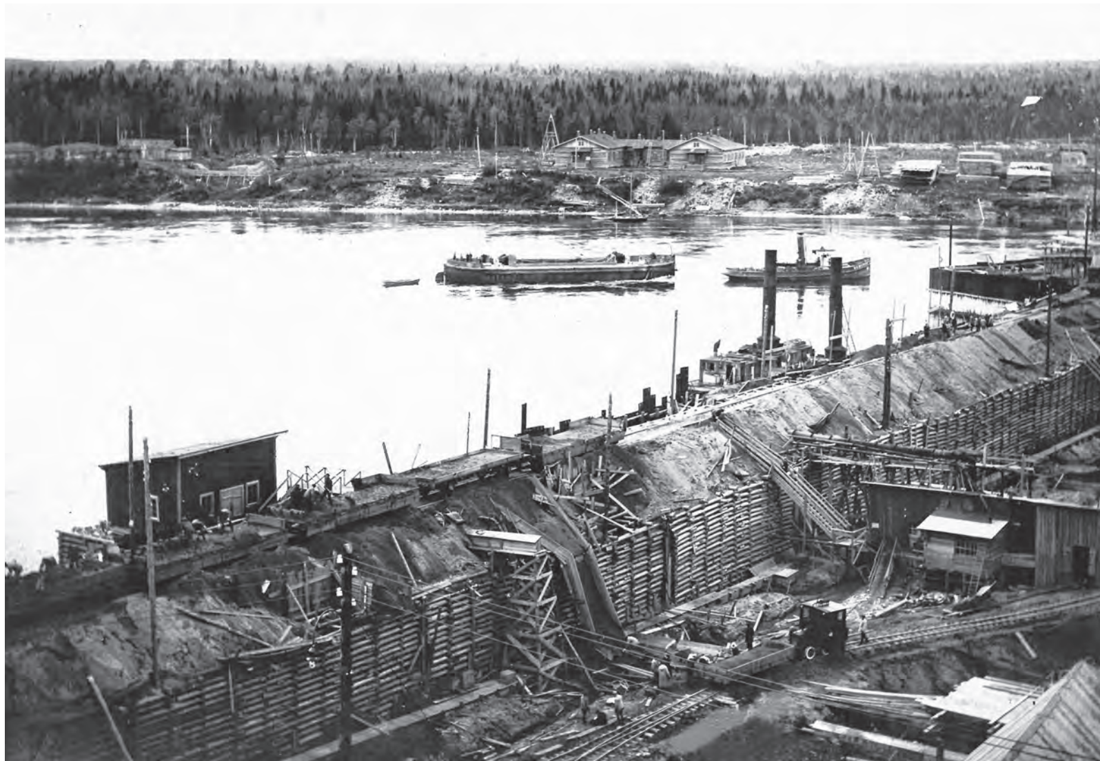
◀ Сооружение плотины Нижне-Свирской ГЭС Dam construction at Nizhne-Svirskaya HPP
