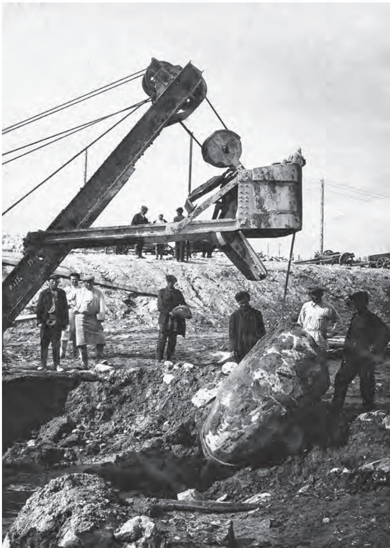
◀ Выкорчевка валунов экскаватором на Нива ГЭС-2 Extraction of boulders using excavators at Niva HPP-2
