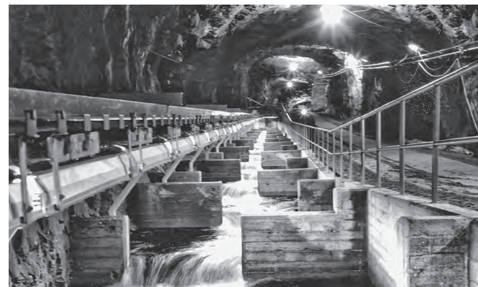
▲ Верхне-Тулумская ГЭС. Рыбоход Verkhne-Tulomskaya HPP. Fishway
