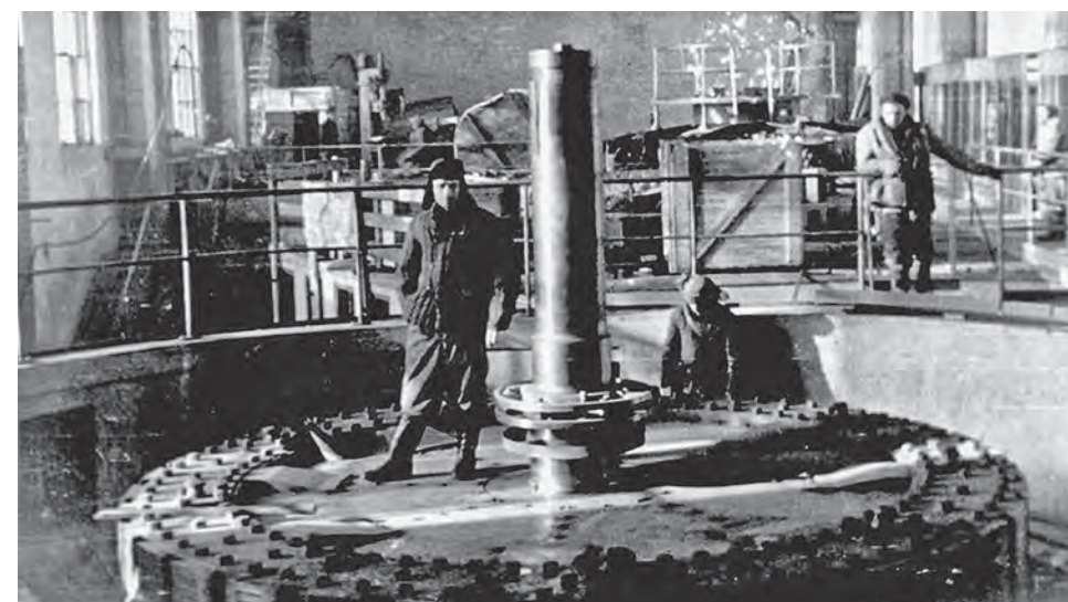
► Монтаж гидроагрегатов Кондопожской ГЭС Hydroelectric unit installation at Kondopozhskaya HPP
