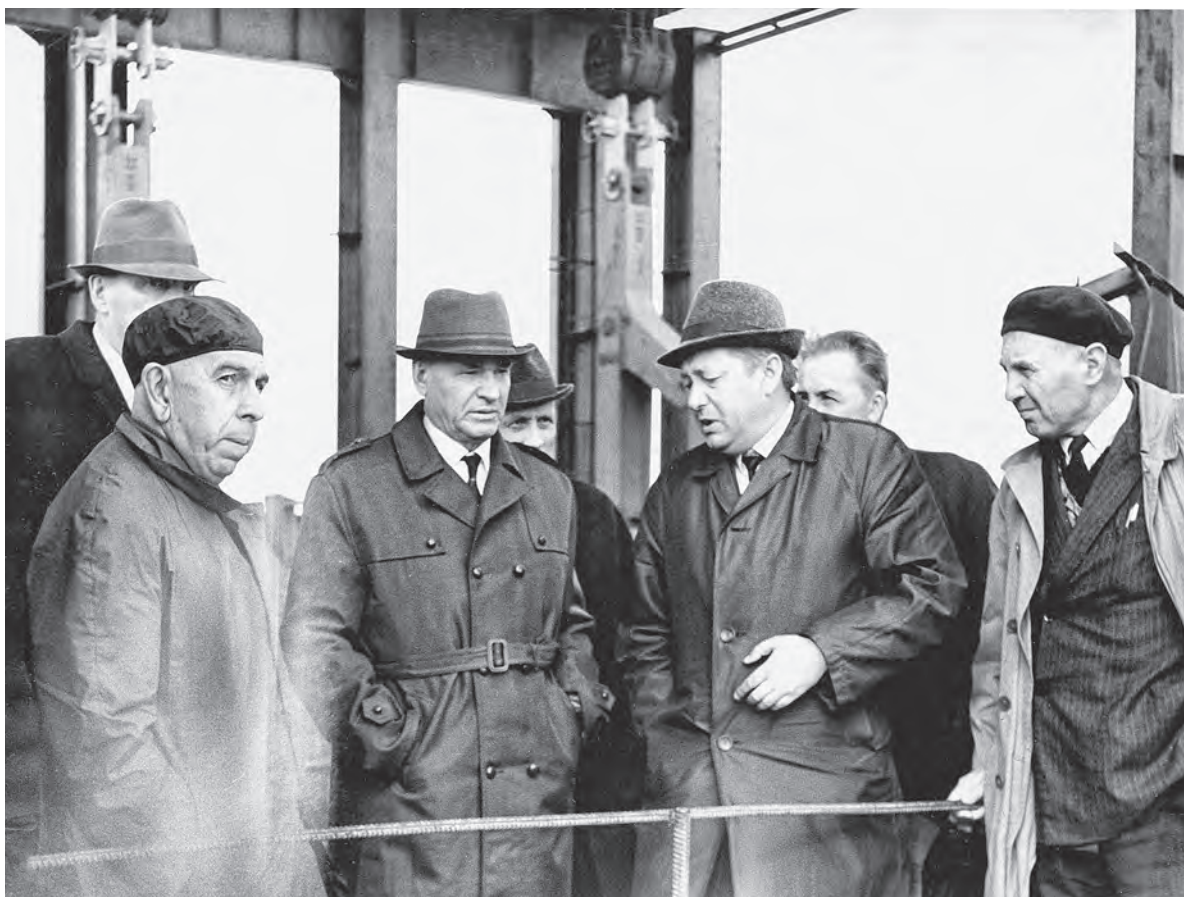
▲ Министр энергетики П. С. Непорожний на приемке Хевоскоски ГЭС
