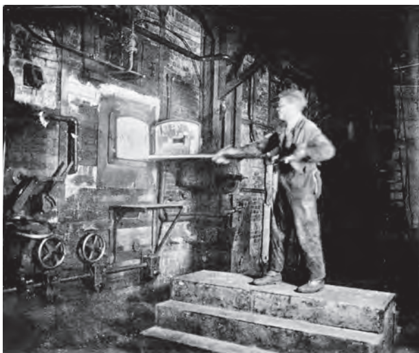
▲ Кочегар у котла электростанции «Общества электрического освещения 1886 года»
