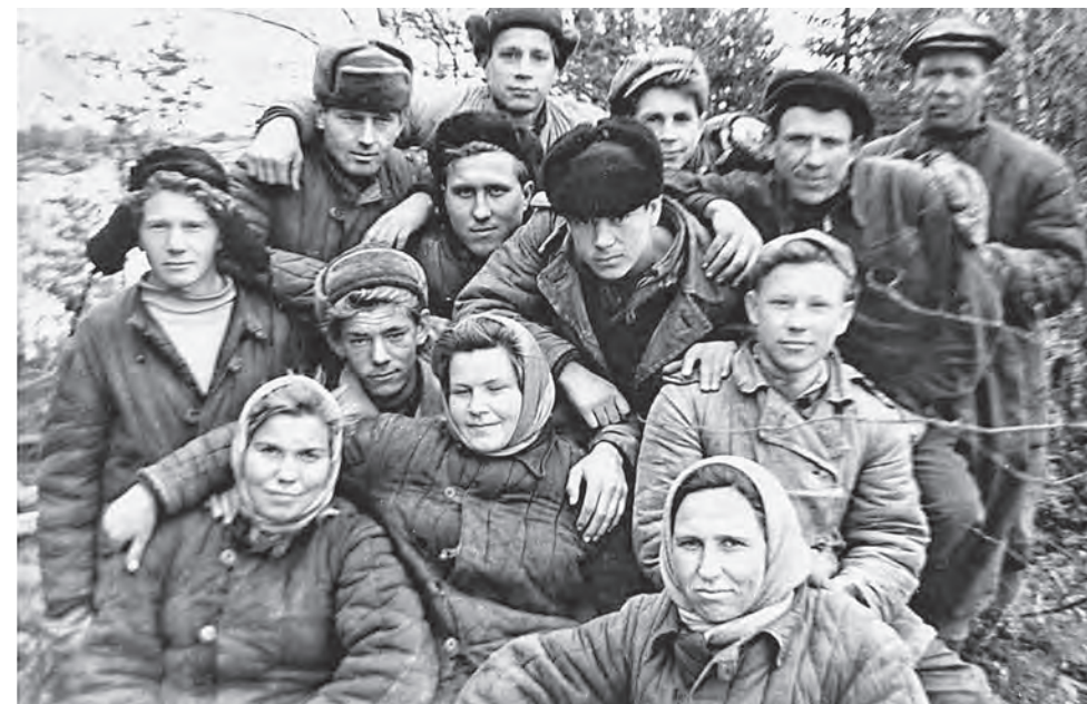
▲ Беломорская ГЭС. Строители станции
