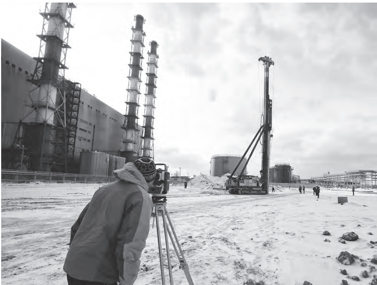
Первомайская ТЭЦ. Установка первой сваи объединенного вспомогательного корпуса Pervomayskaya CHPP. First pile of an integrated auxiliary building
