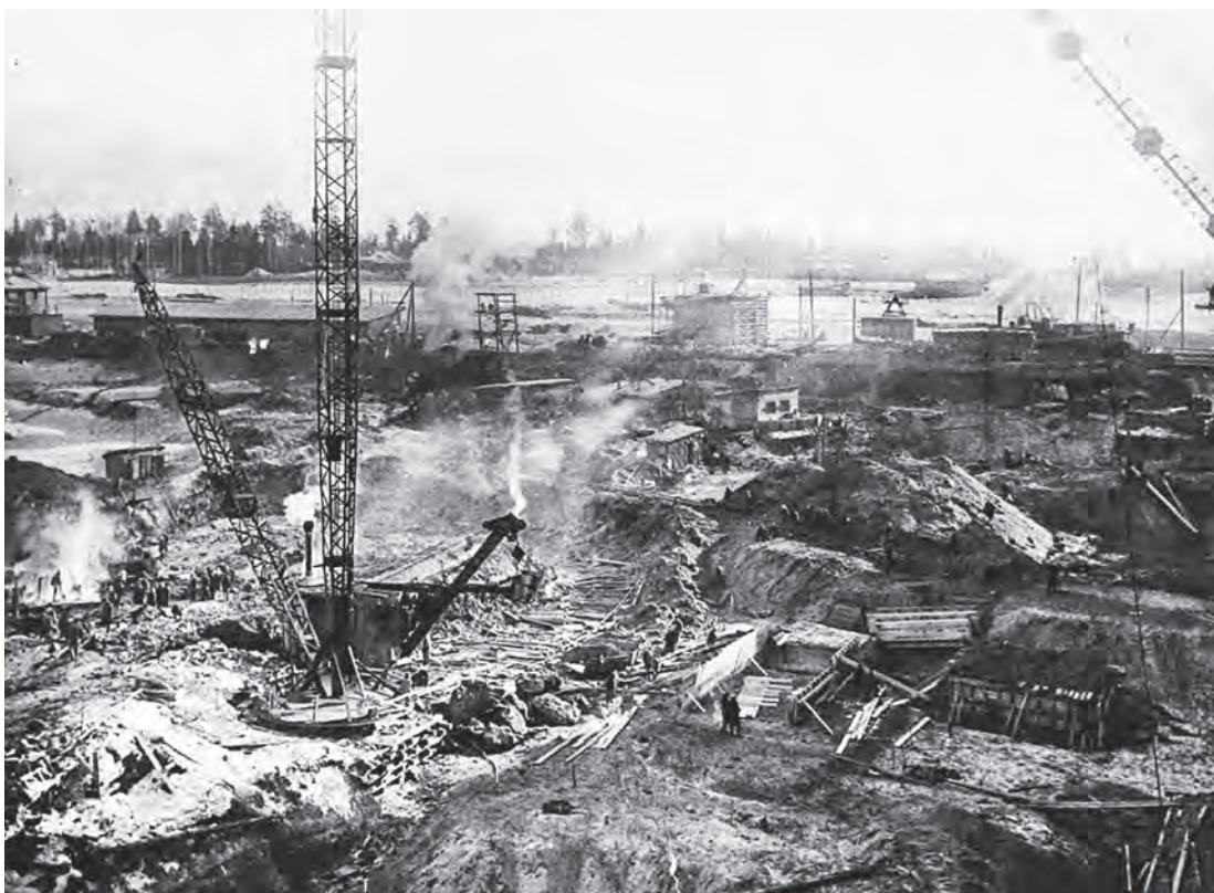
▲ Строительство Нижне-Свирской ГЭС Construction of Nizhne-Svirskaya HPP
