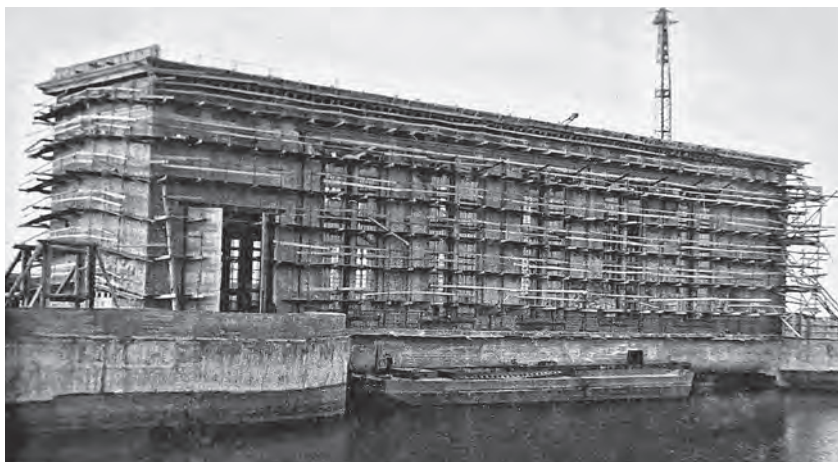
◀ Строительство Маткожненской ГЭС Construction of Matkozhnenskaya HPP
