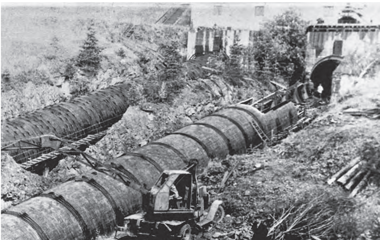
▲ Кондопожская ГЭС. Монтаж напорных трубопроводов
