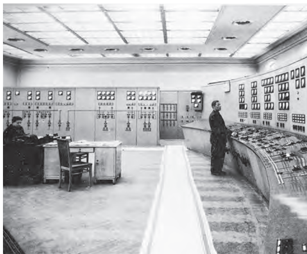
◀ Главный щит управления ТЭЦ-15 Main control panel at CHPP-15
