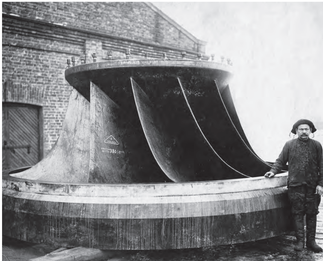
Рабочее колесо первой турбины Волховской ГЭС Running wheel of the first turbine at Volkhovskaya HPP
