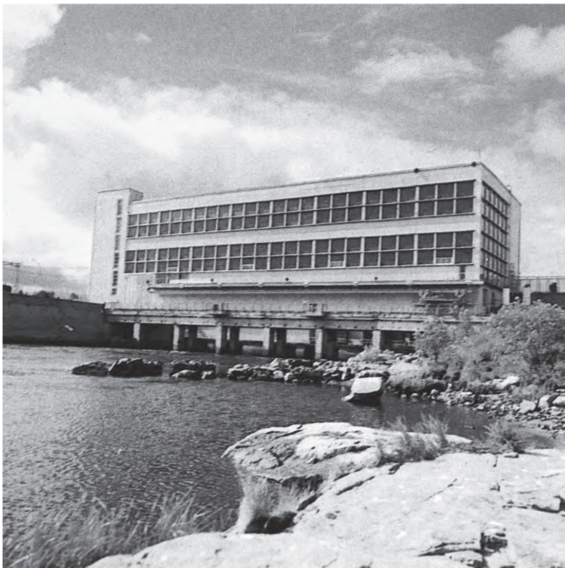
◀ Палокоргская ГЭС. Вид с нижнего бьефа Palokorgskaya HPP. View from the downstream
