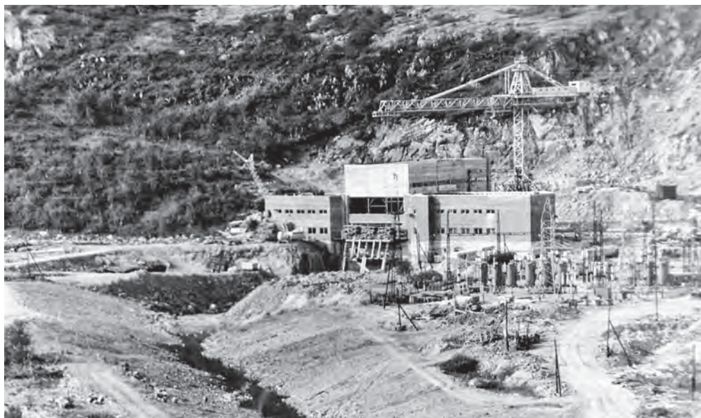
◀ Верхне-Териберская ГЭС. Панорама строительства
