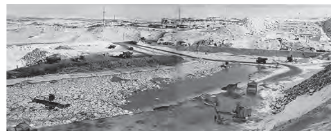
◀ Серебрянская ГЭС-1. Возведение земляной плотины
