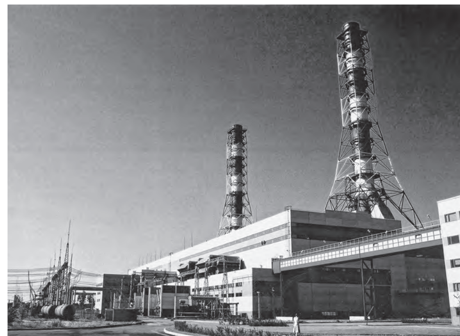
Северо-Западная ТЭЦ ▶ Severo-Zapadnaya CHPP
