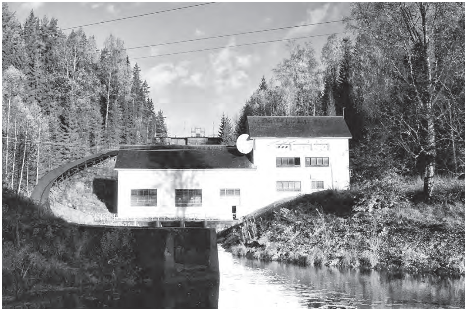
▲ Питкякоски ГЭС Pitkakoski HPP
