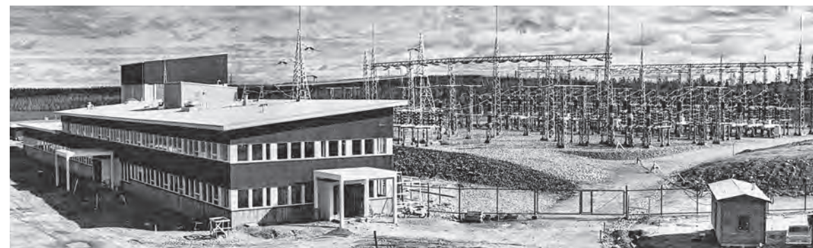
Верхне-Тулумская ГЭС Verkhne-Tulomskaya HPP
