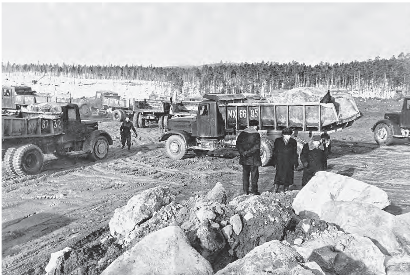
Иовская ГЭС. Строительство плотины
