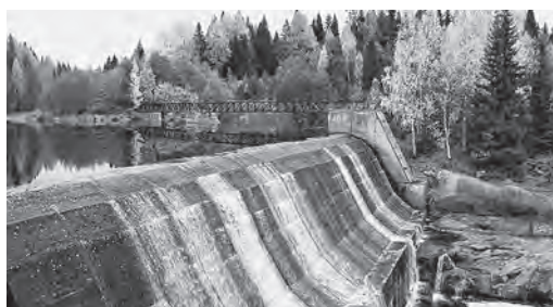
◀ Пиени-Йоки ГЭС. Водосливная плотина Pieni-Joki HPP. Spillway dam
