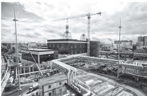
▲ Строительство нового энергоблока ЭС-1 Центральной ТЭЦ Construction of a new power generating unit at PP-1 at Centralnaya CHPP
