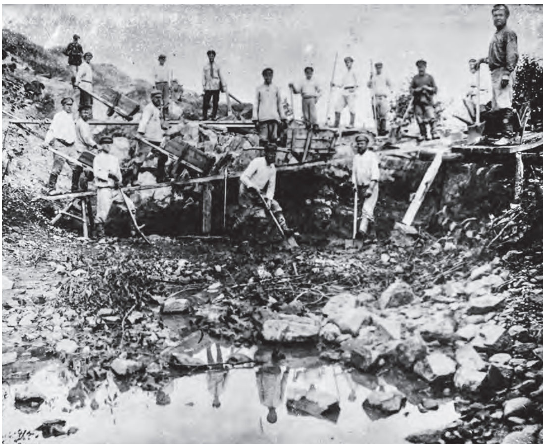
▲ Кондопожская ГЭС. Группа рабочих на строительстве отводящего канала
