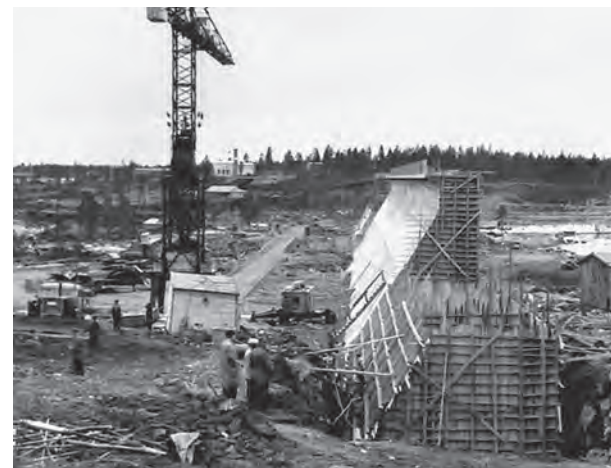
◀ Строительство Раякоски ГЭС Rayakoski HPP construction
