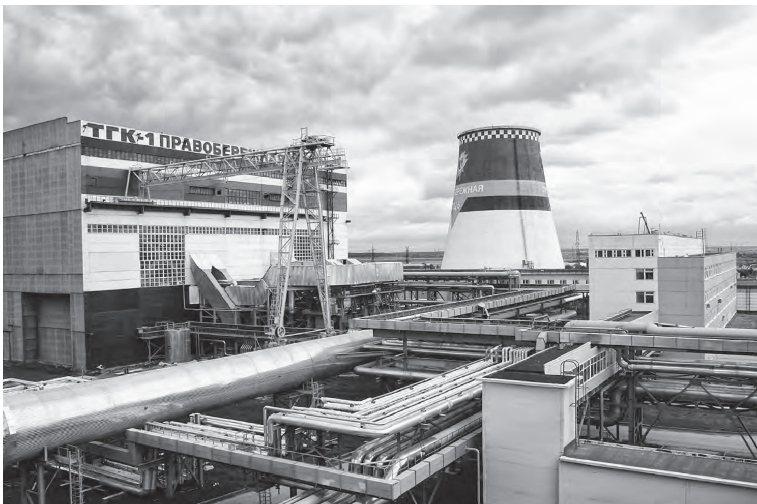
▲ Правобережная ТЭЦ. Первая очередь Pravoberezhnaya CHPP. First stage
