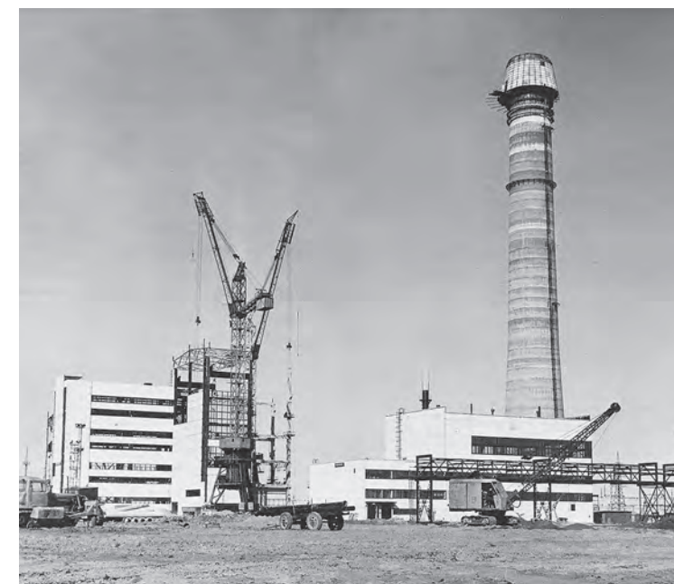
Северная ТЭЦ. Строительные работы на станции Severnaya CHPP Construction work on site
