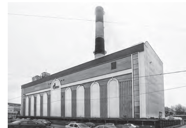
Здание закрытого распределительного устройства 110/6 кВ ЭС-2 Центральной ТЭЦ Indoor 110/6 kV switchgear was commissioned at PP-2 at Centralnaya CHPP
