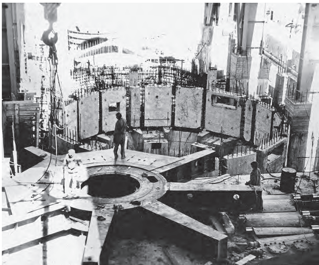
▲ Кривопорожская ГЭС. Монтаж оборудования Krivoporozhskaya HPP. Equipment assembly
