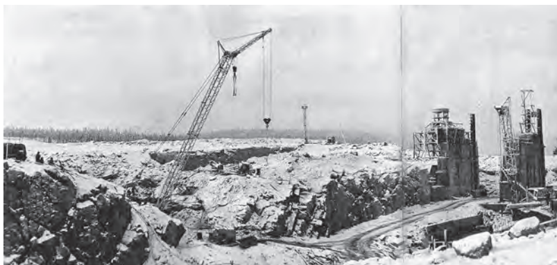
◀ Кривопорожская ГЭС. Строительство водосброса Krivopozhskaya HPP. Water discharge construction
