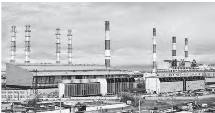
▲ Первомайская ТЭЦ. Новый блок Pervomayskaya CHPP. New unit
