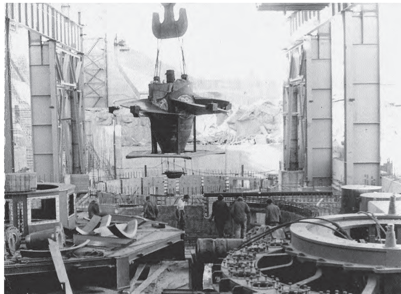
Кривопорожская ГЭС. Монтаж оборудования Krivoporozhskaya HPP. Equipment assembly
