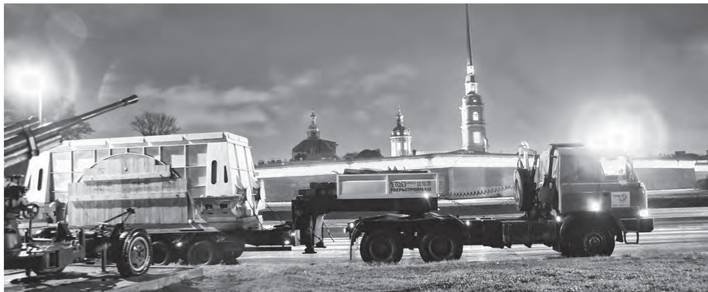
▲ Транспортировка турбины на Василеостровскую ТЭЦ Turbine transportation to Vasileostrovskaya CHPP
