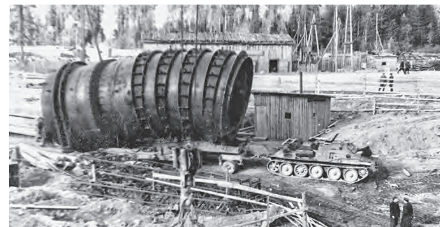
Иовская ГЭС. Транспортировка секции напорных водоводов
