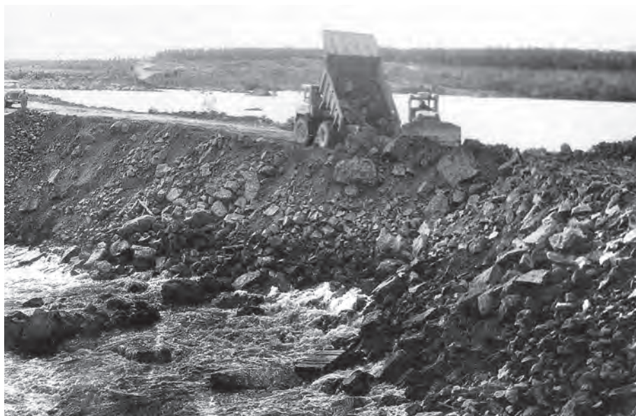
Кривопорожская ГЭС. Перекрытие верхнего бьефа Krivoporozhskaya HPP. Shut down the headwaters
