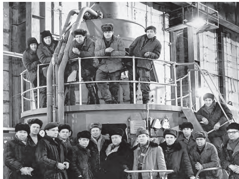
▶ Серебрянская ГЭС-1. Строители Serebryanskaya HPP-1. Builders
