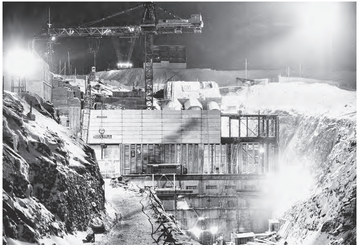
▲ Серебрянская ГЭС-2. Панорама строительства Serebryanskaya HPP-2. Panoramic view of the construction site
