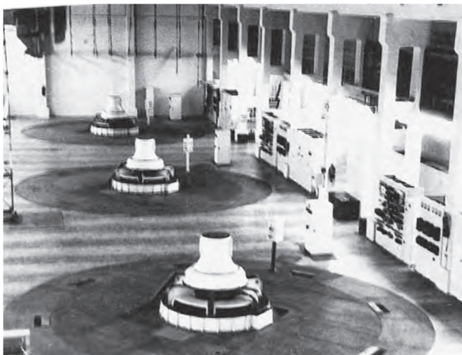
◀ Машинный зал Путкинской ГЭС Turbine hall at Putkinskaya HPP
